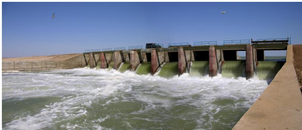
*Рис. 2. Гидроузел Кокарал (водосбросное сооружение).
