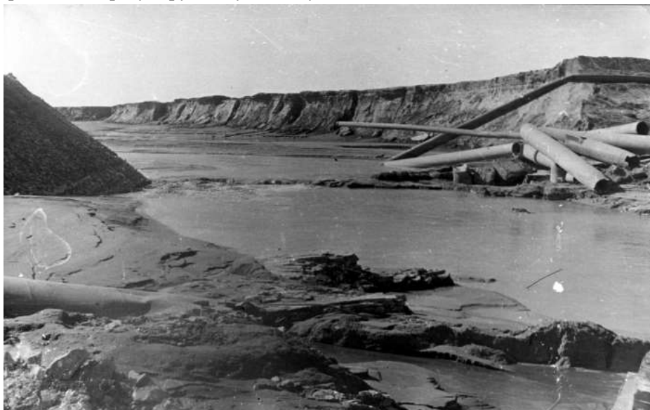
Рис. 3. Вид на проран после аварии.
