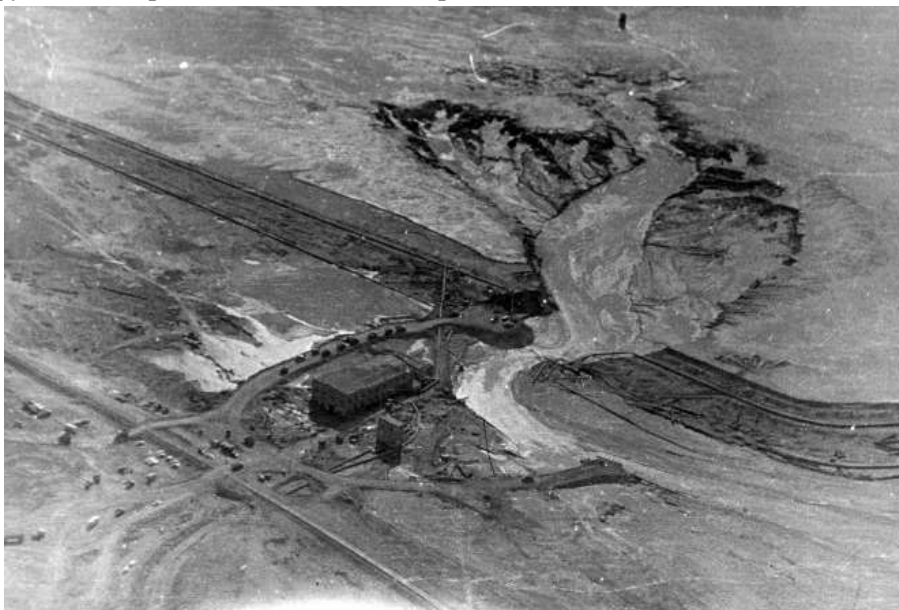
Рис. 2. Вид на хвостохранилище после аварии с высоты птичьего полета.
