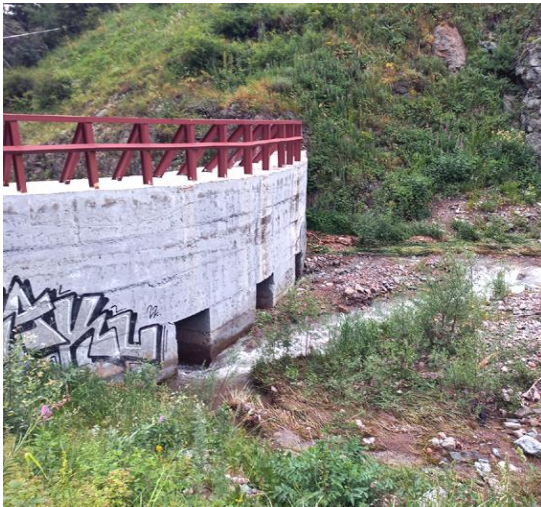
Рис. 10. Железобетонная плотина с металлическим сквозным сооружением на гребне. Фото Р.К. Яфязовой
