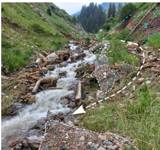
Рис. 12. Отложения селя 30 июня 2024 г. выше металлической сквозной плотины. 1 – временный поток воды; 2 – разрушенные габионы; 3 – поверхность скольжения оползня. Фото Р.К. Яфязовой
