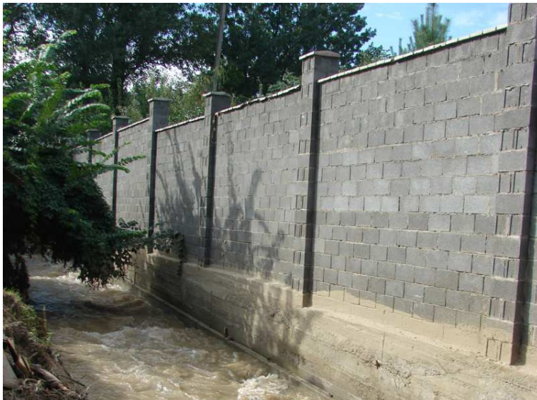
Рис. 4. Левый (орографически) борт канала – железобетонная конструкция.
