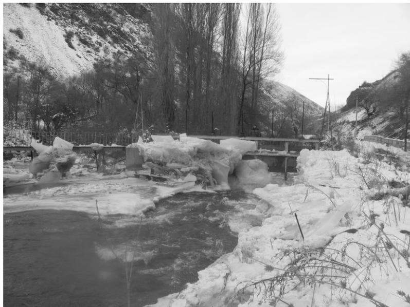
*Рис.6. Перехват снежноледовых масс вододелителем.*
