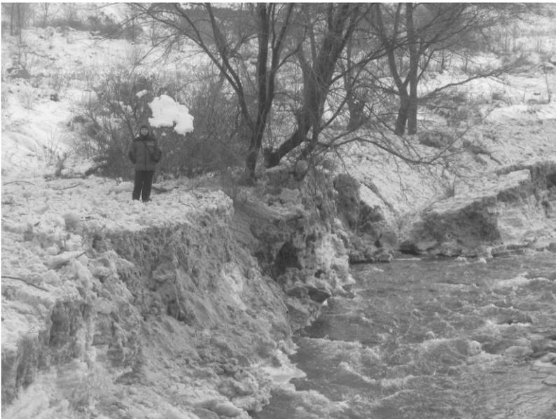
*Рис.5. Снежноледовые отложения (мощностью более 3 м) в верхнем бьефе плотины.*
