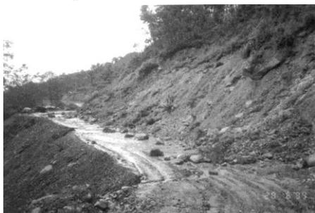
*Рисунок 4 – Участок дороги, поврежденный оползнем.*
