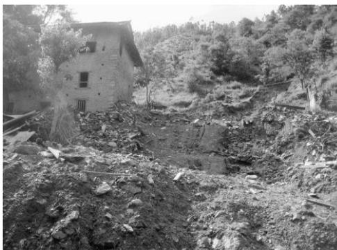
*Рисунок 3 – Оползень, вызвавший разрушение жилых строений.*
