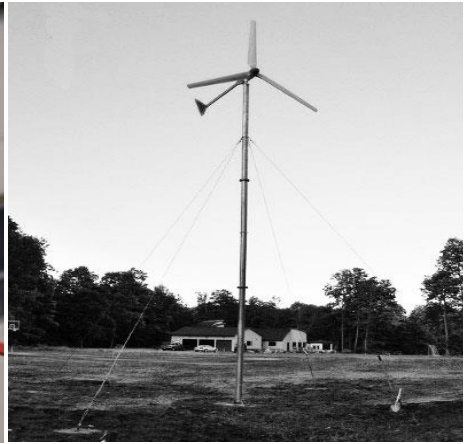
Рис. 2. Ветроэлектрическая станция FD3.0-1000 [3]
