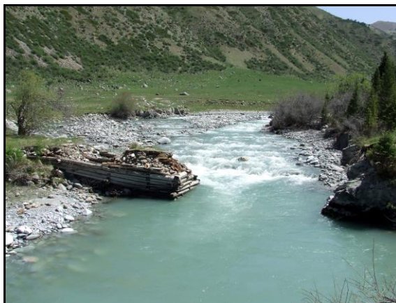
Рис. 2. Старый деревянный мост, разрушенный несколько лет назад водоледовым селем.
