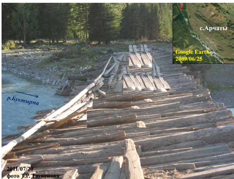
Рис. 5. Мост через р. Буктырма в районе села Арчаты.
