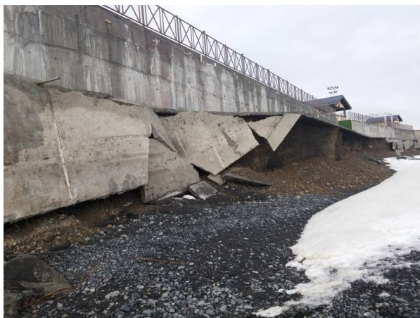
Рис. 3. Остатки водобойной стенки для защиты зоны отдыха п. Акиш (февраль 2018 г.).
