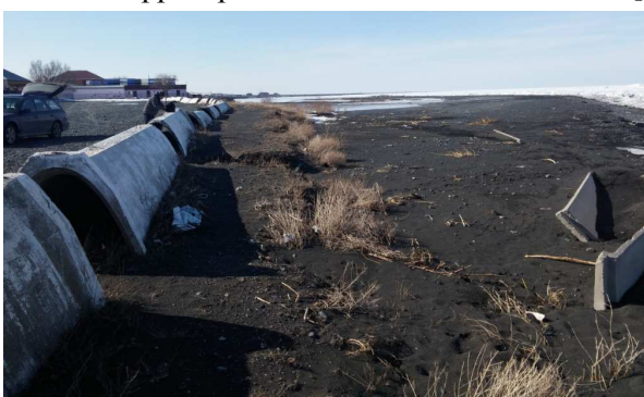
Рис. 2. Установка поливочных лотков для защиты от волн (февраль 2018 г. п. Акиш).
