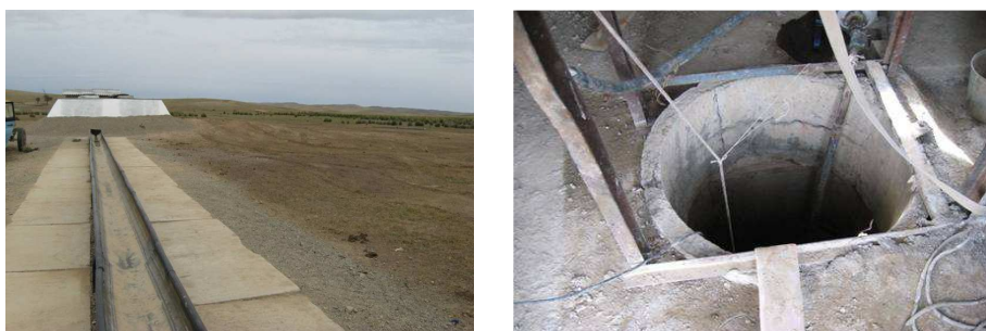
Рис. 4. Колодезь «Басу» после восстановления. 2010 г.
