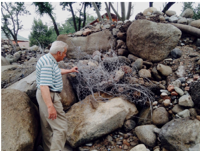
Рис. 3. Остатки габиона после прохождения «вторичного» селя на р. Каргалинка.
