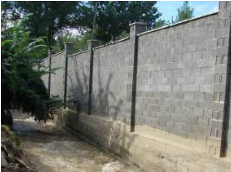
Рис. 4. Левый (орографически) борт канала – железобетонная конструкция.
