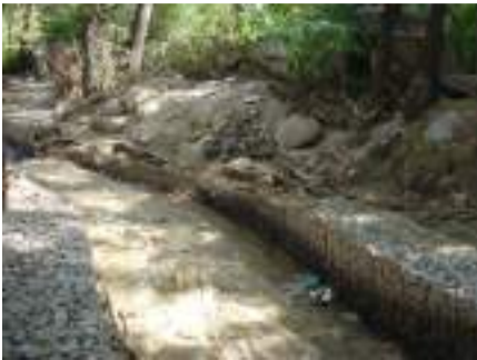
Рис. 6. Разрушение габрионов под действием центробежной силы.
