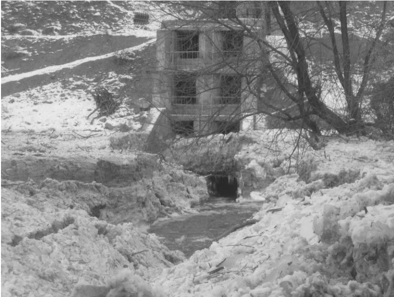
Рис.4. Водоприемное устройство селезащитной плотины на р. Узункаргалы (вид с верхнего бьефа).
