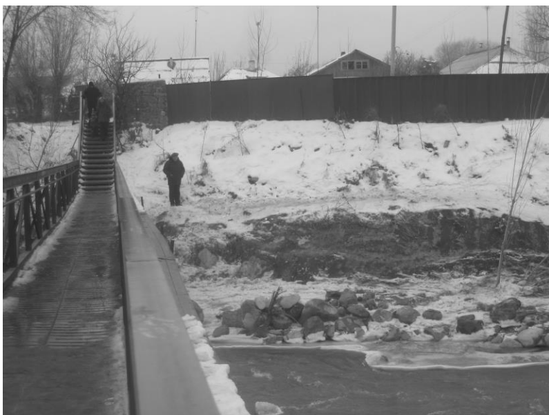
Рис.8. Пешеходный мост в центре пос. Фабричный (длина 33 м). Человек стоит на отметке максимального уровня водоснежноледового потока (около 5 м).
