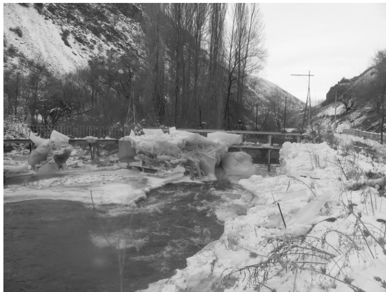
Рис.6. Перехват снежноледовых масс вододелителем.
