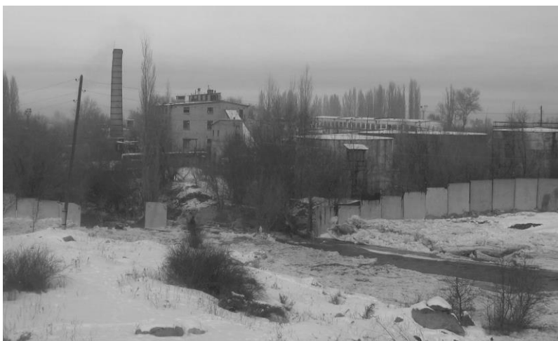
Рис.7. Брешь, пробитая водоснежноледовой массой в железобетонном заборе суконной фабрики.
