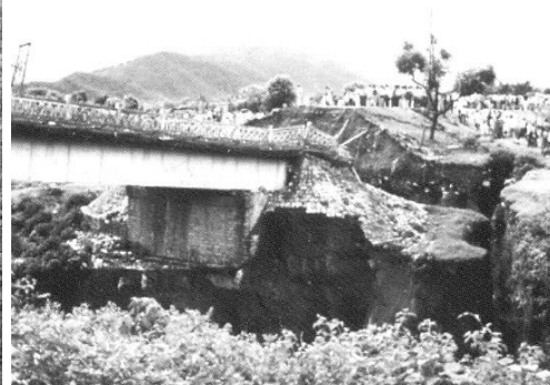
Рисунок 8 – Скол, расчленивший дорожное полотно.
