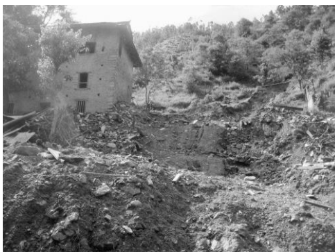
Рисунок 3 – Оползень, вызвавший разрушение жилых строений.
