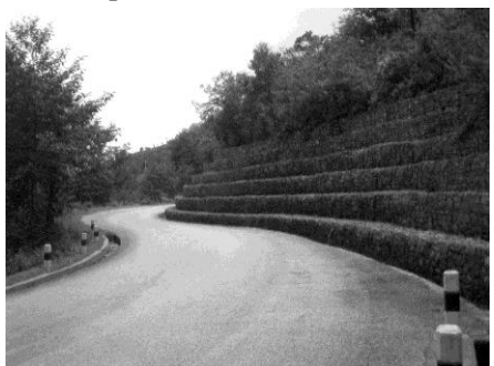
Рисунок 5 – Тот же участок дороги после проведения восстановительных работ.
