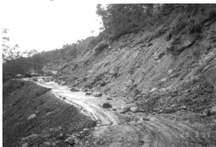
Рисунок 4 – Участок дороги, поврежденный оползнем.
