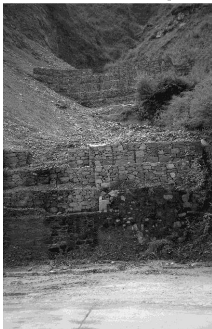
Рисунок 6 – Стабилизация русла временного водотока барражами с целью защиты автомобильной дороги.
