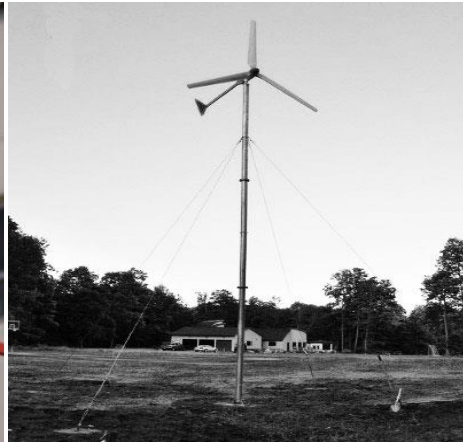
Рис. 2. Ветроэлектрическая станция FD3.0-1000 [3]
