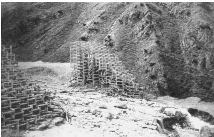
Рис. Плотина на р. Герхожансу (Россия, Северный Кавказ), разрушенная селевым потоком 20 августа 1999 г.
