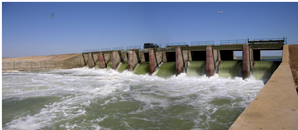
Рис. 2. Гидроузел Кокарал (водосбросное сооружение). а) – верхний бьеф; б) – нижний бьеф.
