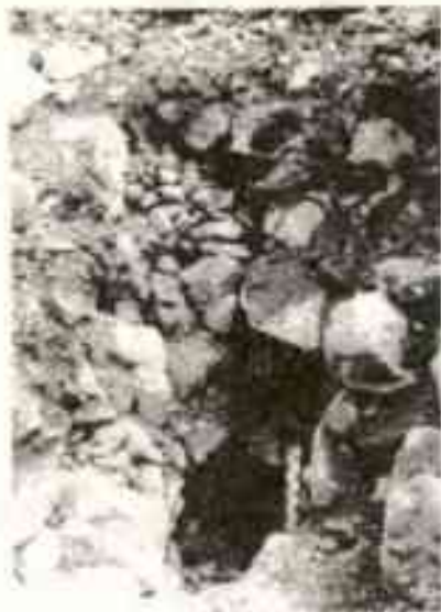
Рис. 5. Вскрытие шурфом подземного канала стока.
