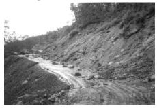
Рисунок 4 — Участок дороги, поврежденный оползнем.
