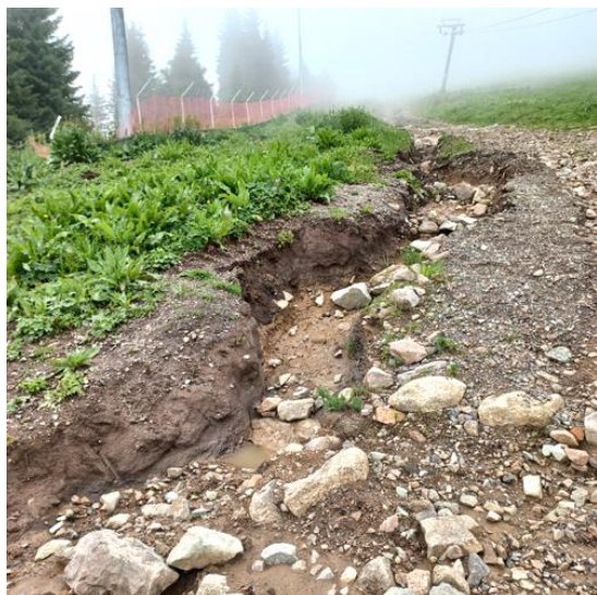
Рис. 4. Грунтовая дорога, размытая микроселем во время дождя. Фото Р.К. Яфязовой
