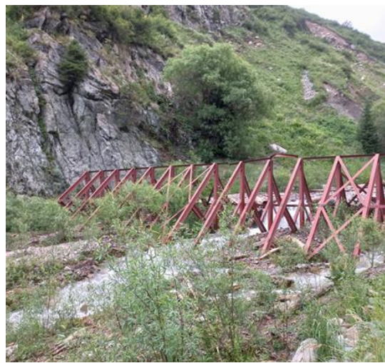
Рис. 11. Металлическая сквозная плотина. Фото Р.К. Яфязовой
